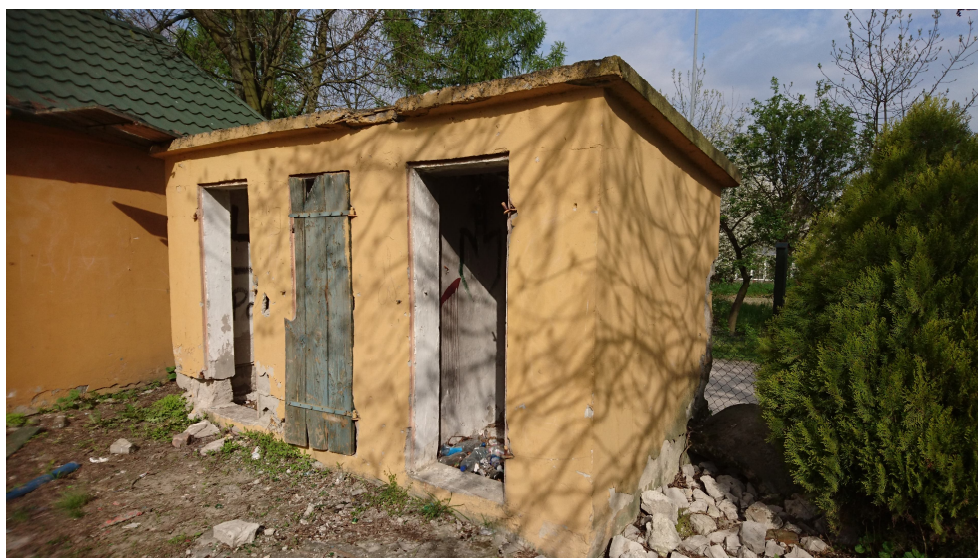
Fot.6 Elewacja wschodnia budynku wc.
