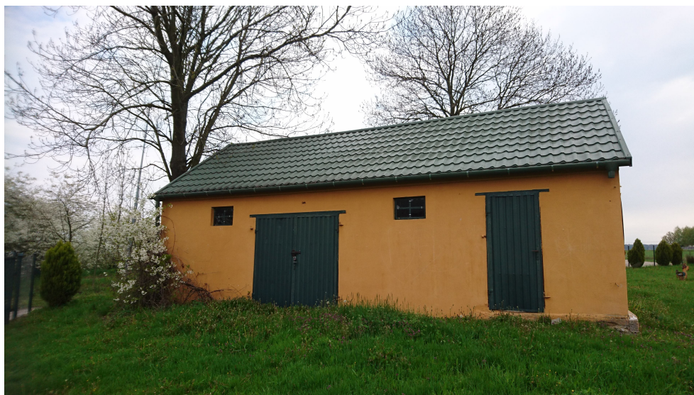
Fot.3 Elewacja południowo-zachodnia budynku gospodarczego.
