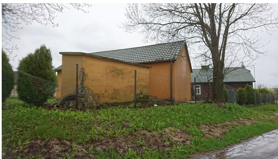
Fot.2 Elewacja północno-zachodnia budynku gospodarczego i wc.
