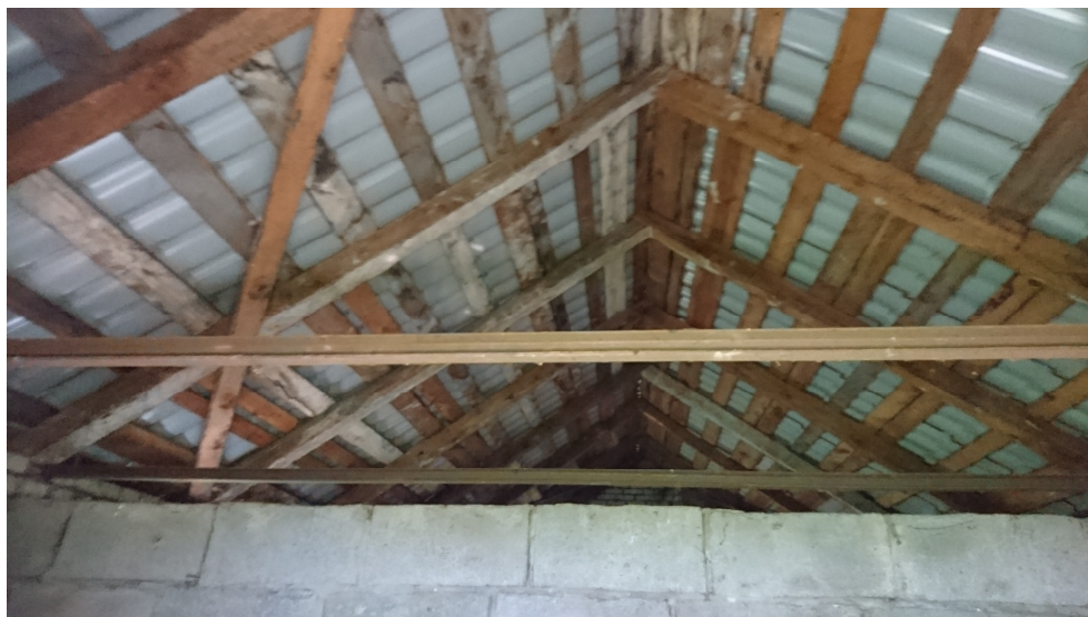
Fot.5 Więżba dachowa budynku gospodarczego.
