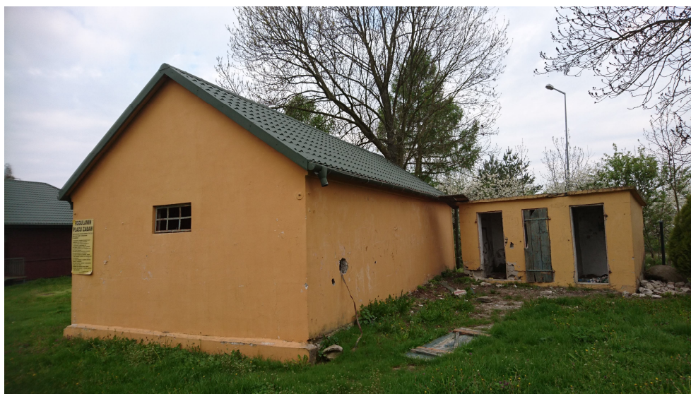
Fot.1 Elewacja wschodnia budynku gospodarczego i wc.
