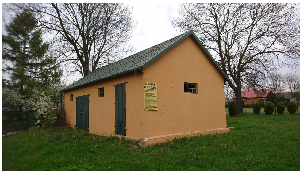
Fot.4 Elewacja południowo-wschodnia budynku gospodarczego.
